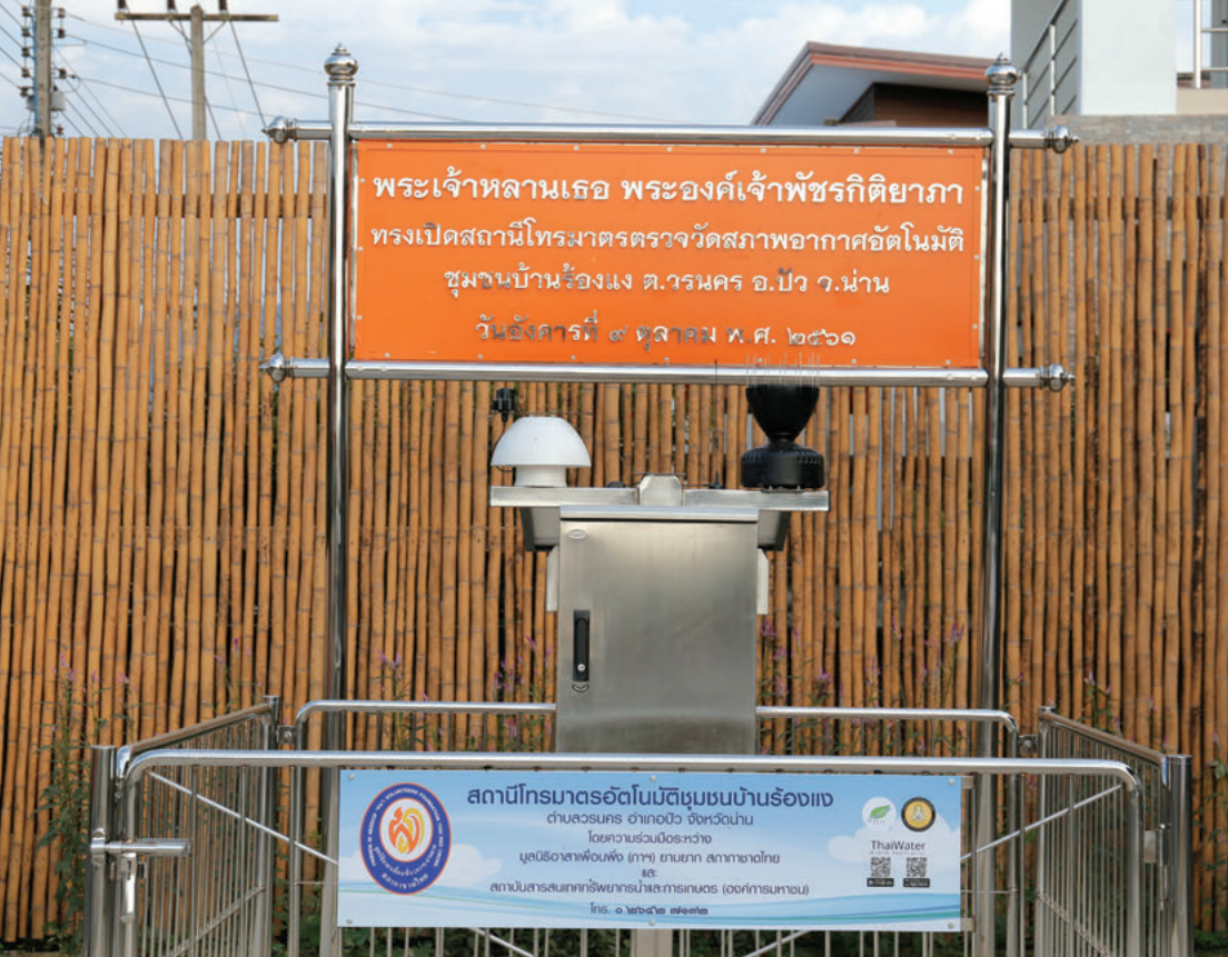
สถานีโทรมาตรตรวจวัดสภาพอากาศอัตโนมัติ ชุมชนบ้านร้องแง
