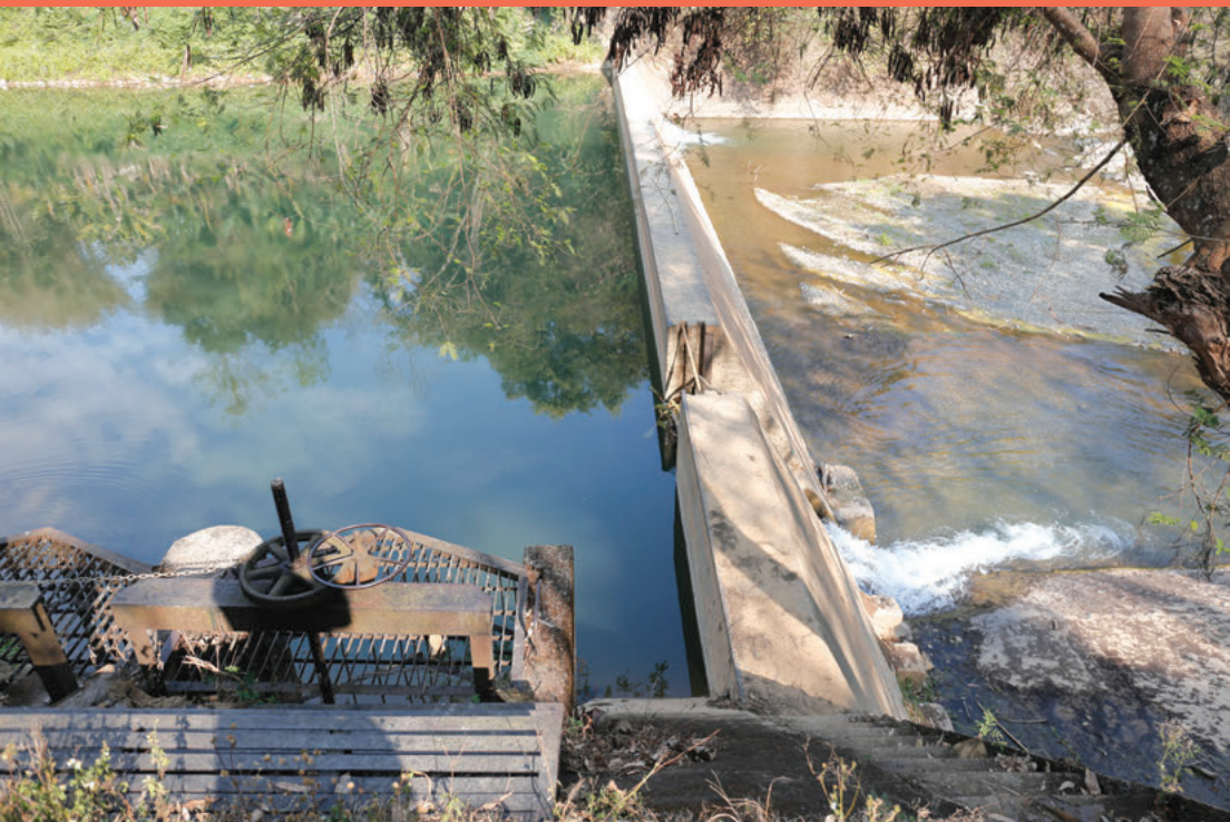
ฝายจ้าวแบบคอนกรีต สร้างโดยกรมชลประทาน
